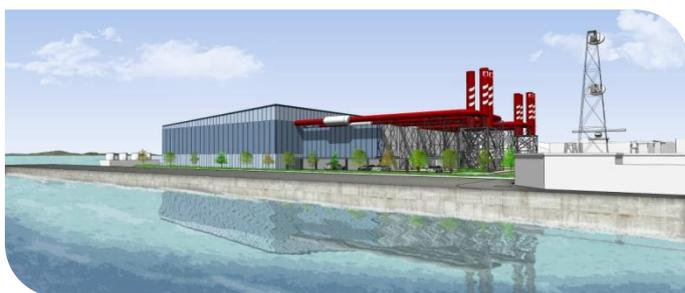
Dans le cadre d'un contrat EPC (Engineering, Procurement and Construction), Bouygues Energies & Services réalisera une centrale « clés en main » en prenant en charge les études de conception, de réalisation et d'impacts environnementaux, la fourniture et la mise en service de 6 groupes moteurs-générateurs de 14 cylindres et 300 tonnes chacun (gaz et fuel). Le
