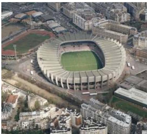
La réalisation du stade a nécessité la mise en œuvre d'une gigantesque coque elliptique constituée de voussoirs préfabriqués en béton. Assemblés sur place par interposition de résines de synthèse, ils ont été mis en place par précontrainte.
