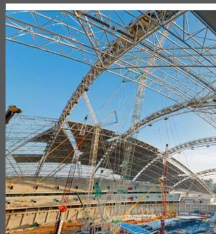
\_ Un toit rétractable de 320 mètres de portée
