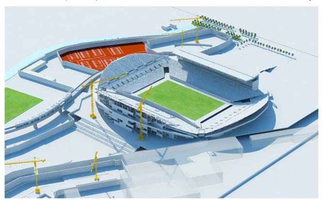
Eté 2012 : mise à disposition de la tribune Ganay, pose de la charpente des virages Nord et Sud, démolition de la tribune Jean Bouin. Couverture du virage Nord.
