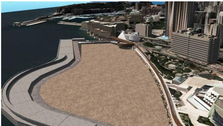
La réalisation l'infrastructure maritime monégasque nécessite également la fourniture importante de matériaux de carrières. Ces matériaux serviront au remblai, à la réalisation du talus et au ballastage des 18 caissons.
