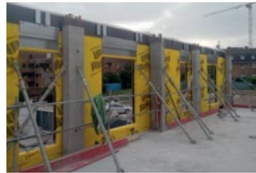
Fruit de la Recherche et Développement du Groupe, « Mix 3 B » permet la pose d'une façade bois dans le cycle du béton dans le processus de construction du bâtiment. Une solution qui cumule les qualités des 2 matériaux
