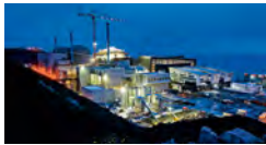
GÉNIE CIVIL INDUSTRIEL
